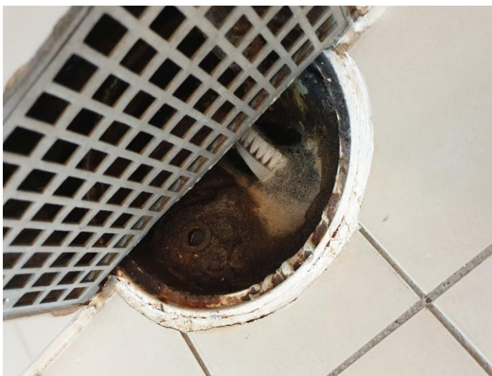
Golvbrunn i original, av gjutjärn
