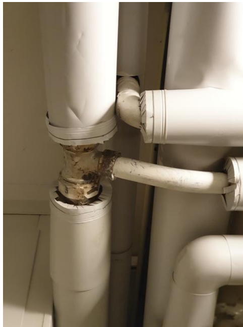
Kall- och varmvattenledningar i rörstråk i källargångar
