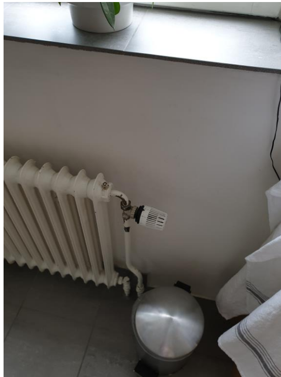
Bytta radiatorventiler med termostat
