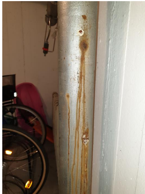
Avloppsstam i källare med rostangrepp
