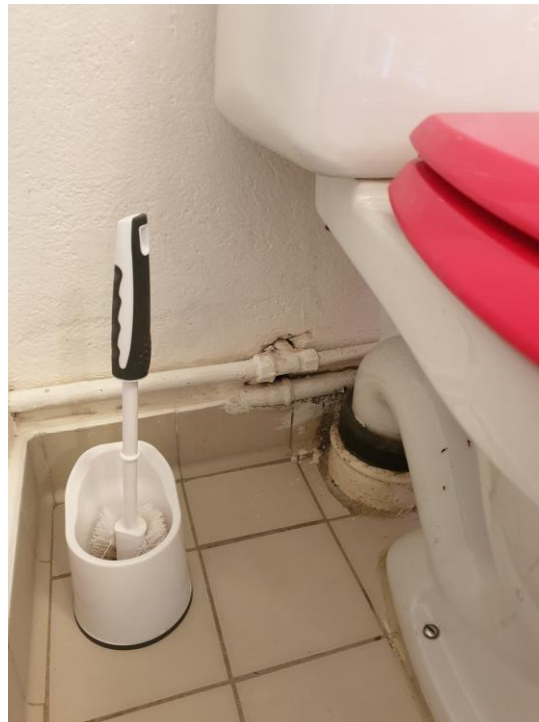
Tappvattenledningar ut ur vägg i badrum, galvaniserat stål och koppar, utan tätning mot vägg
