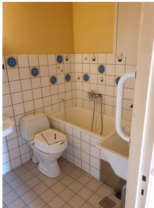
Badrum i originalskick, dåliga ytskikt Rör genomföringar i vägg i våtzon 1
