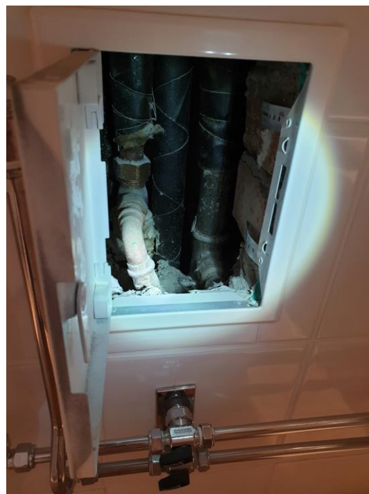
Rörschakt i renoverat badrum Ingen tät botten, ingen läck-ut
