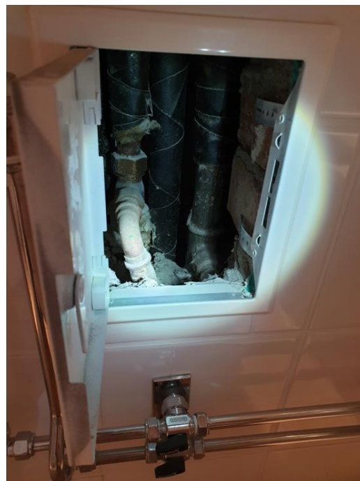
Gamla rörstammar i trånga rörschakt
