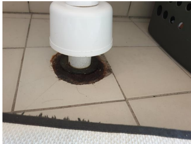
Dåliga avloppsrör i våtrumsgolv
