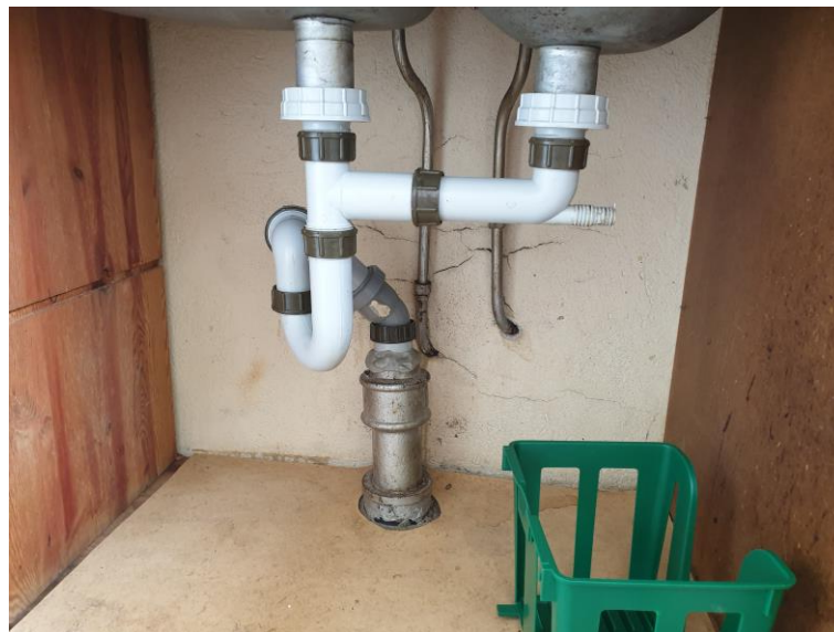
Kök i original med otät botten och dåliga rör
